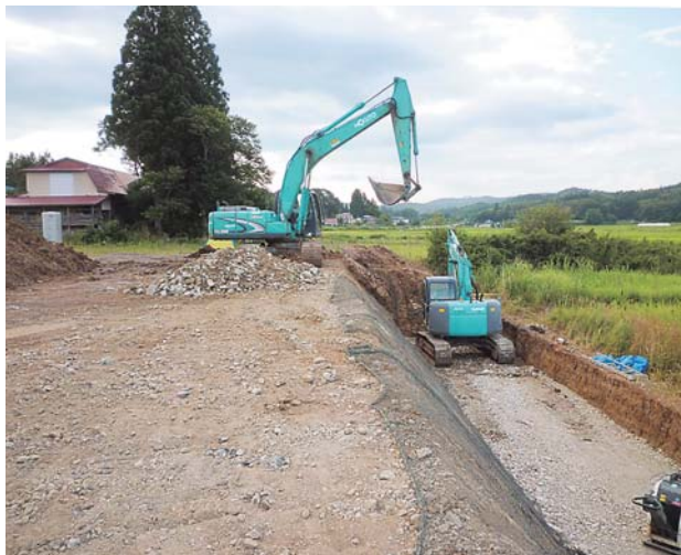
8月 擁壁の基礎工事
