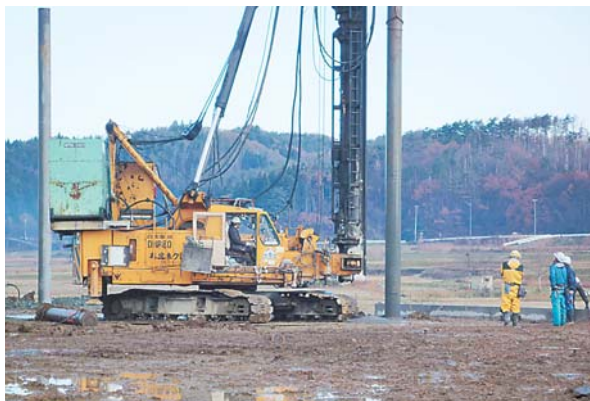
12月 特別養護老人ホームの工事着工
