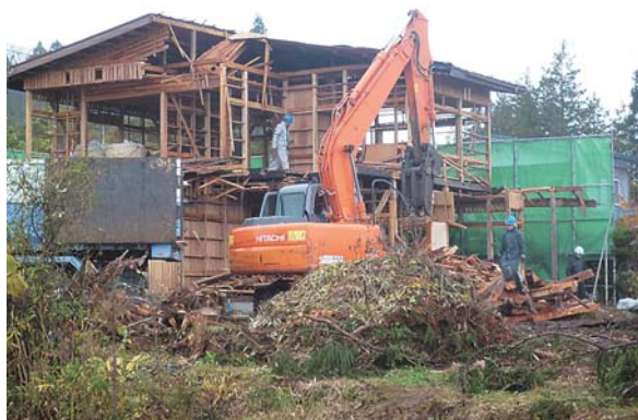
11月 昆野勲さん宅の解体工事
