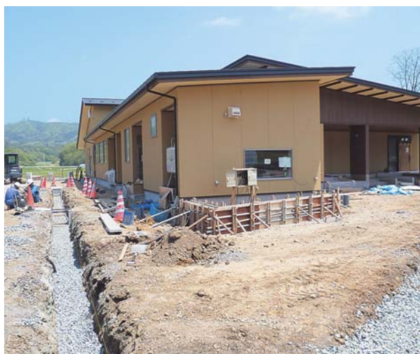
5月 給排水工事
