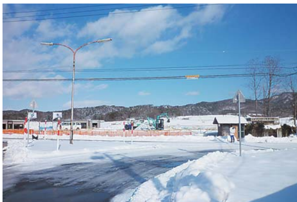
1月 雪の中での基礎工事
