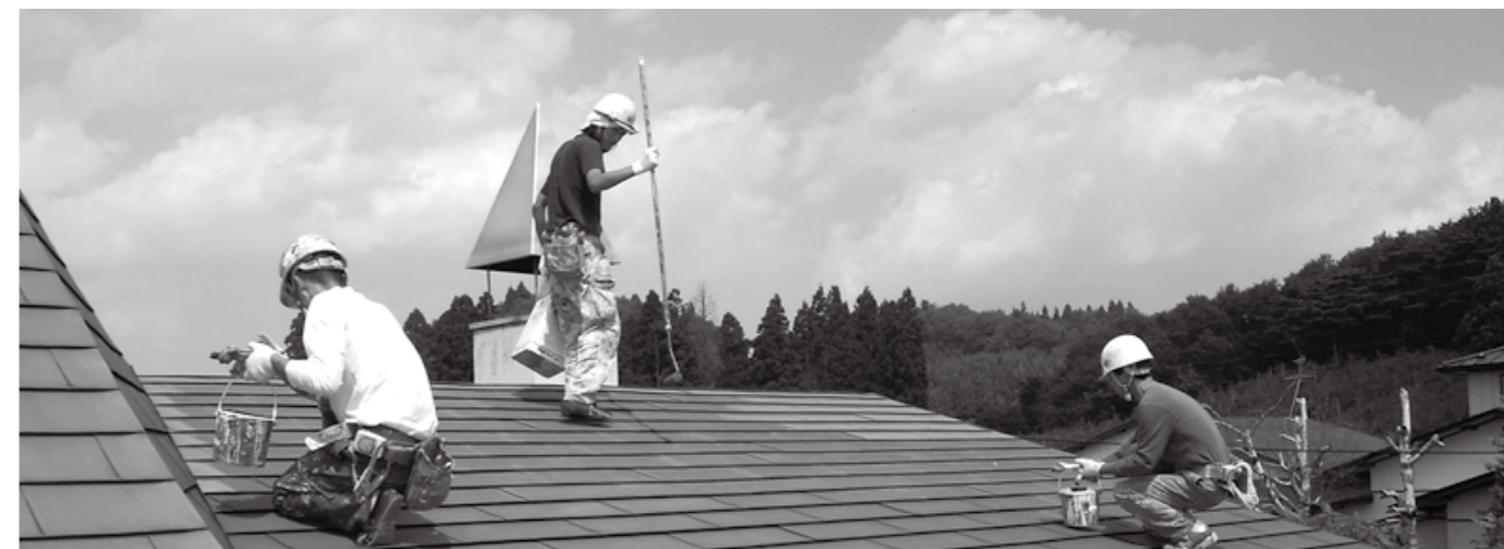
特養八天の里大規模修繕工事（H16.9.3）
