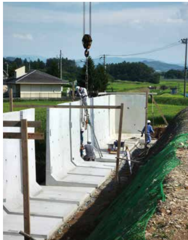
土壌改良・擁壁工事 (H24.8.27)
