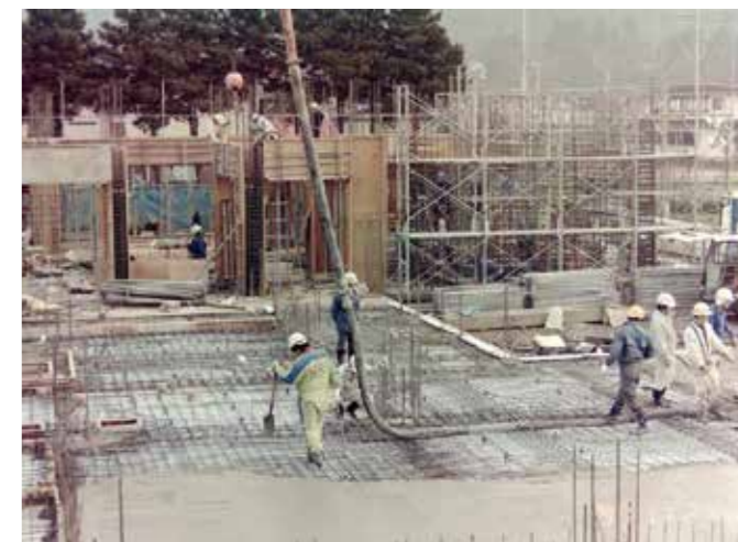
1階土間工事 (H9.11.21)
