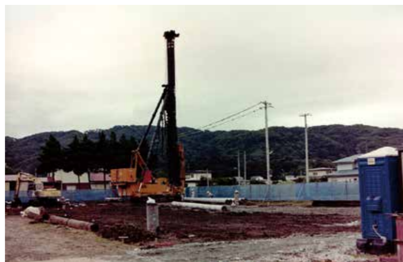
杭打ち工事始まる (H9.9)
