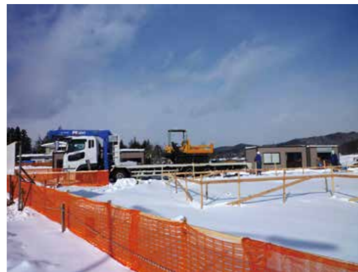
グループホーム、デイ建設工事始まる (H24.12.27)
