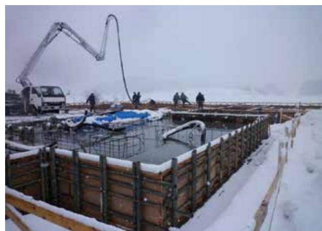
グループホーム土間工事 (H25.2.8)
