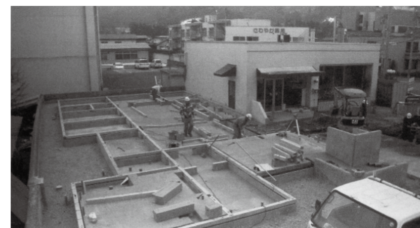
さくらまちケアホーム工事（土台敷き H20.3）
