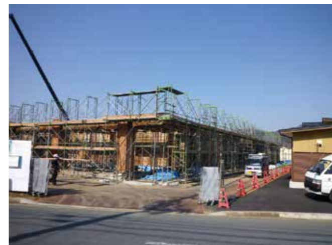
特養浮牛の里建設中 (H26.3.24)
