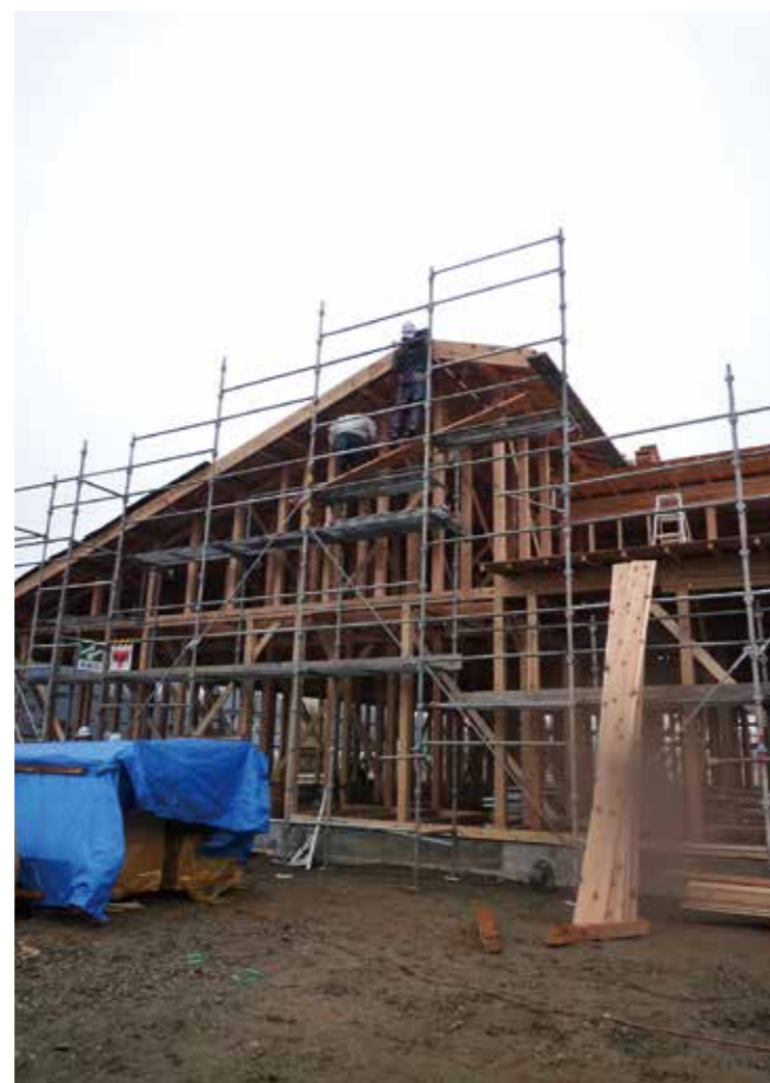
工事現場 (H25.3.18)
