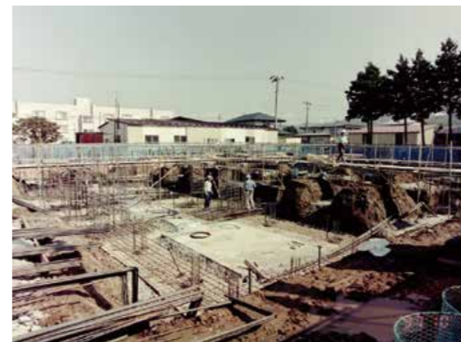
基礎工事 (H9.10.17)
