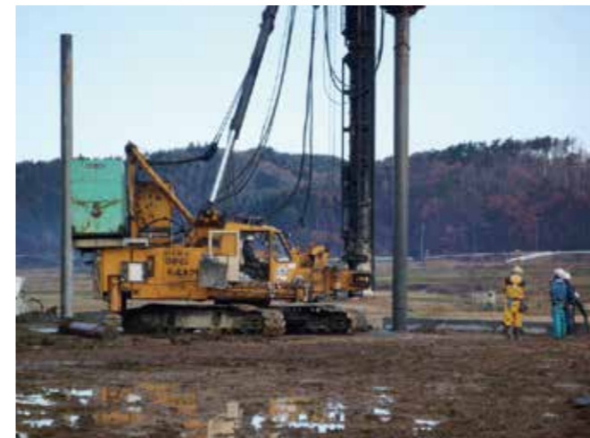
特養の杭打ち始まる (H25.12.3)
