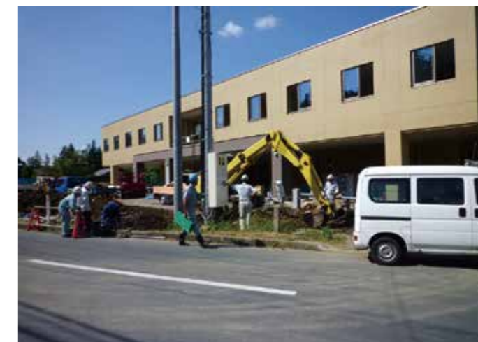
特養完成に向けて急ピッチ (H24.7.2)
