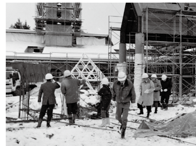
八天の里建設の様子 (H6.1.24)
