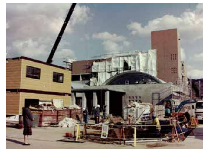
完成に向けて急ピッチ (H10.4.21)
